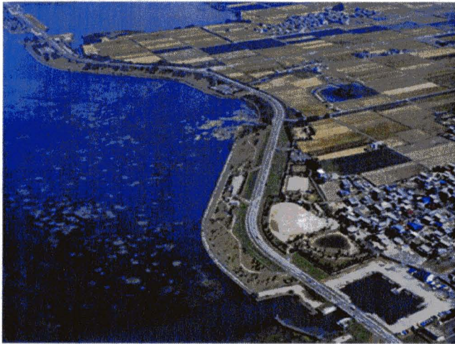
湖岸堤及び管理用道路(水資源機構)
